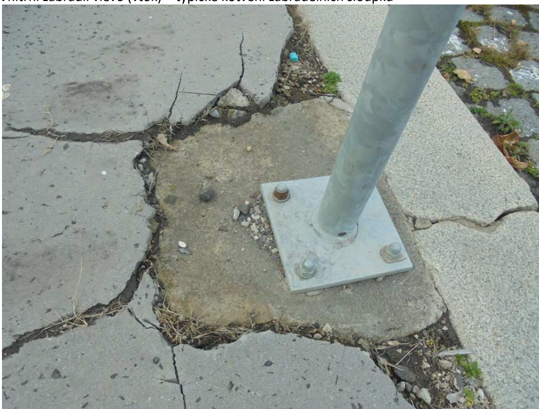
20) Vnitřní zábradlí vlevo (vtok) – typické kotvení zábradelních sloupků
