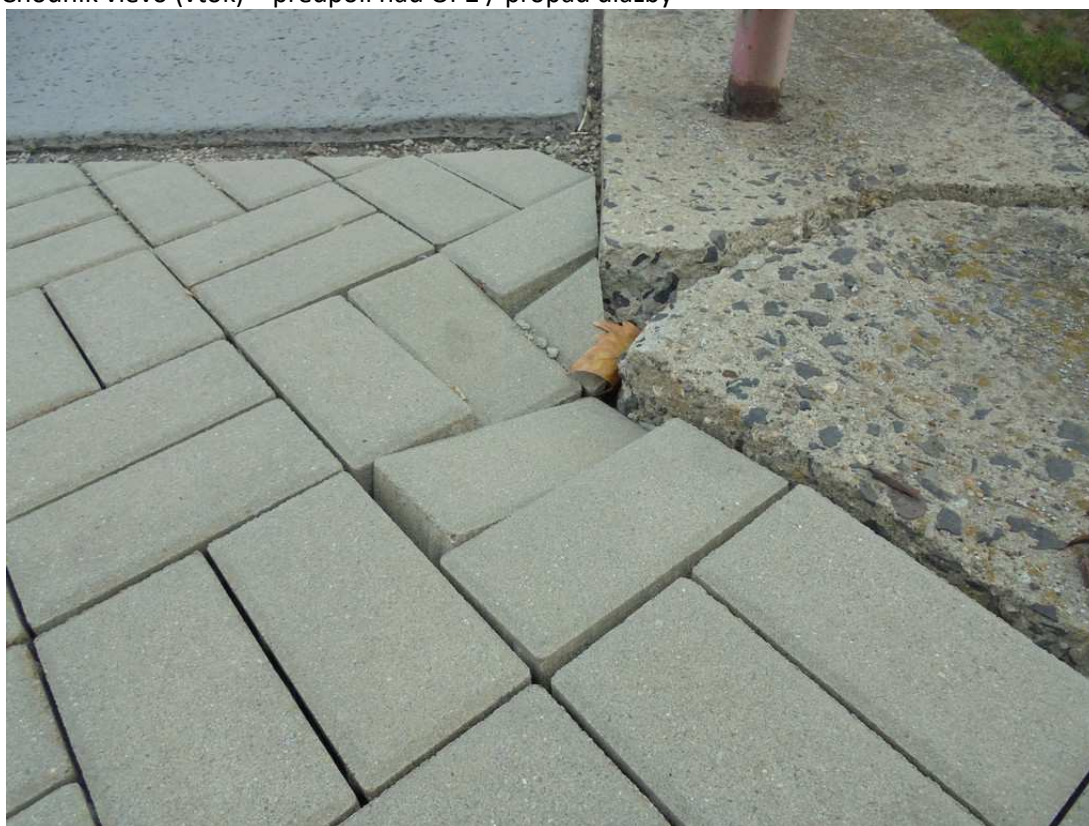
14) Chodník vlevo (vtok) – předpolí nad OP2 / propad dlažby
